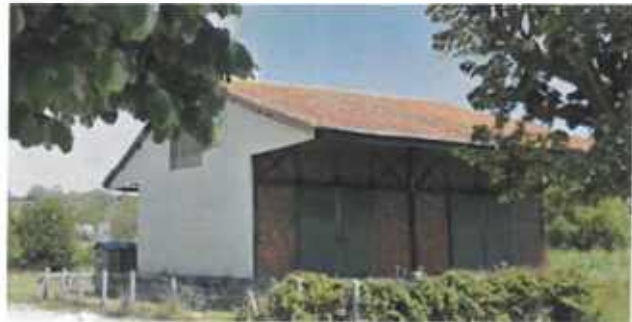
Ancienne gare et hangar de Carteret
