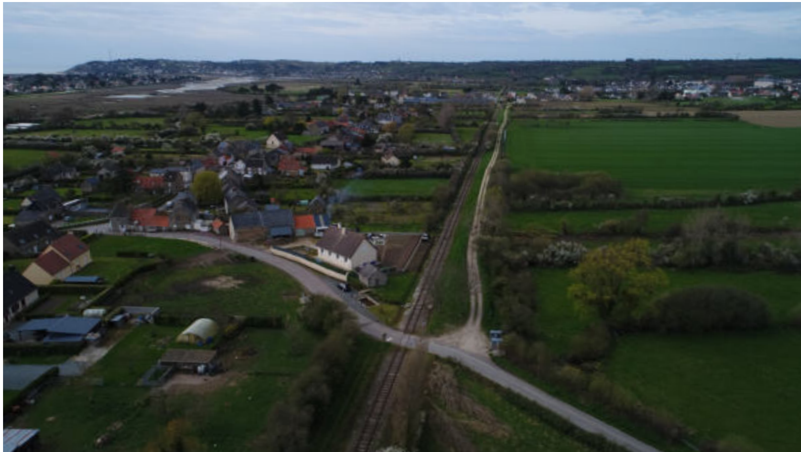
Croisement entre le Chemin de la Gare et Les Rivières.
