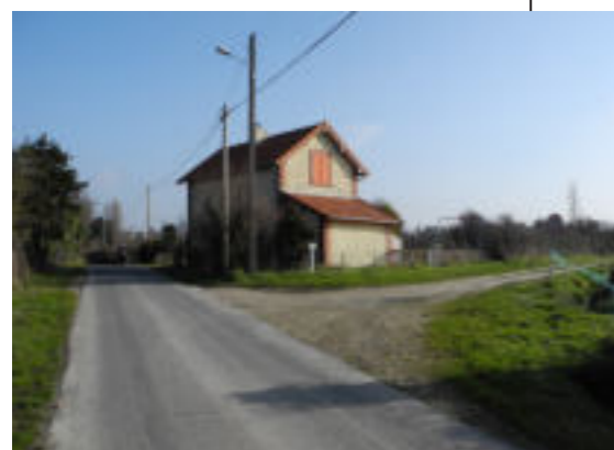
Connexion à l'actuel vélo-route - Chemin du Tôt
