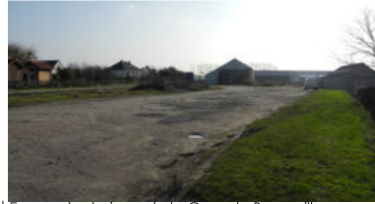
Espace technique de la Gare de Barneville
