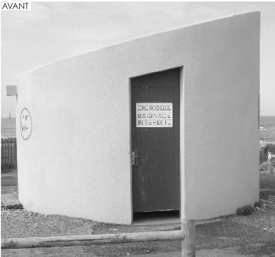
Habillage sanitaires existants, Site de la Paracou, Les Sables d'Olonne, Phytolab.
