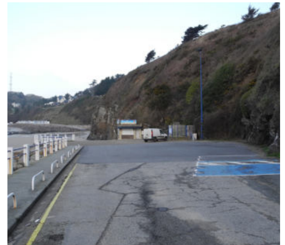
Deuxième partie du parking de la Potinière.
