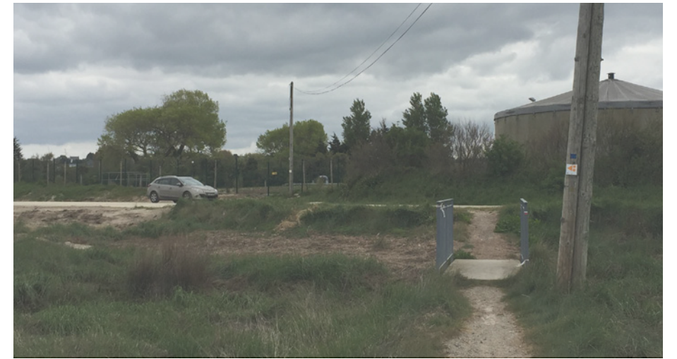
Vue de la station depuis le cheminement.
