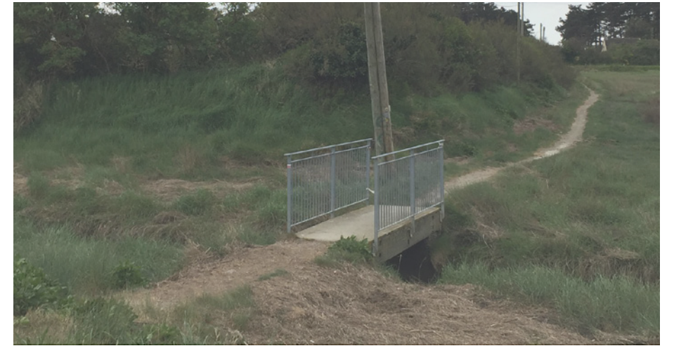
Passerelle étroite pour franchir le Fleuve.
